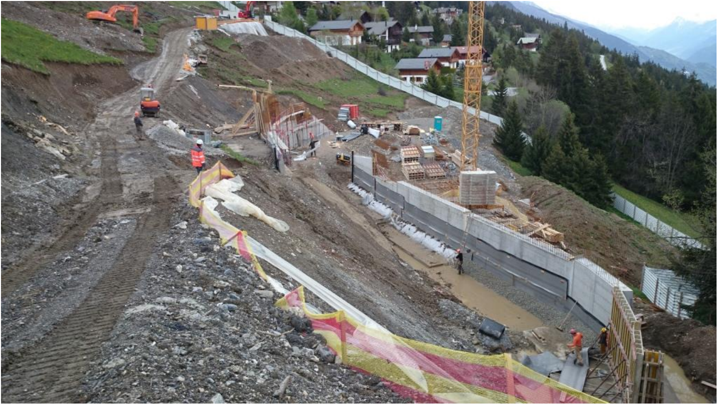
Photo 1 : construction des murs
