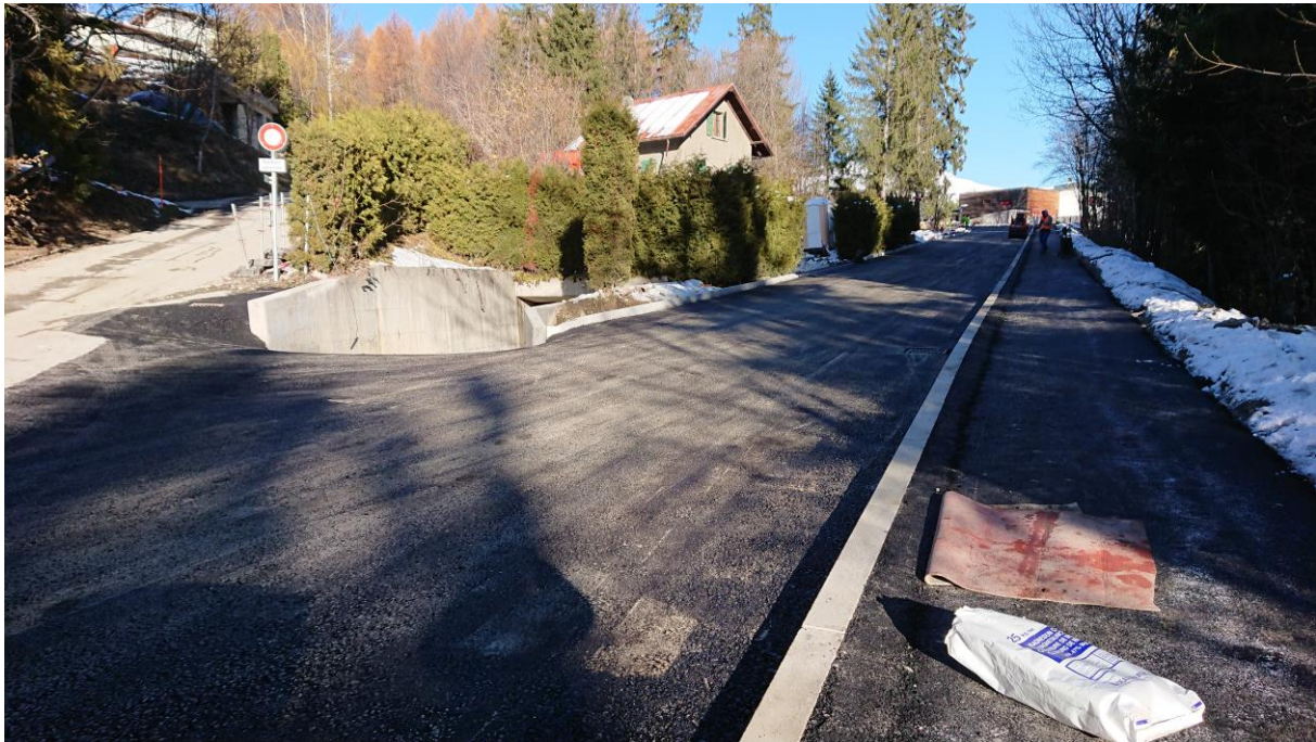
Photo 2: Pose des enrobés Etape 2
