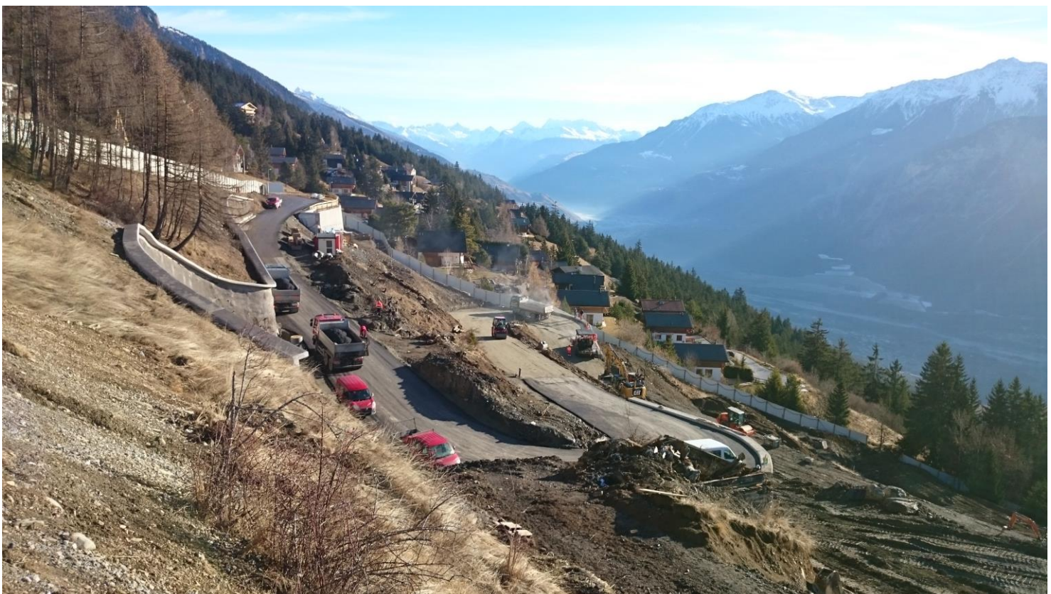
Photo 4 : pose des enrobés
