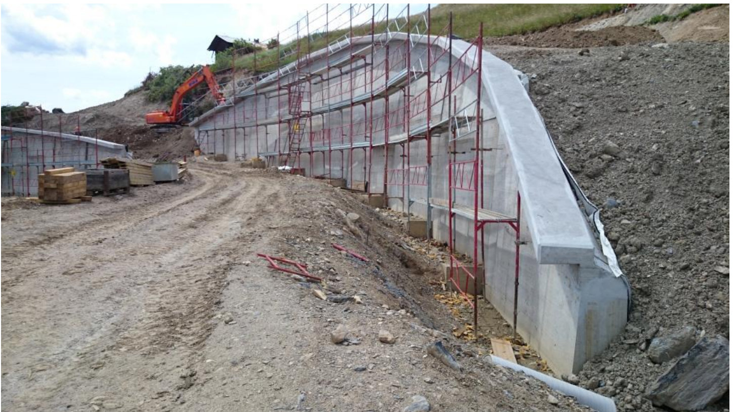
Photo 2 : construction des murs
